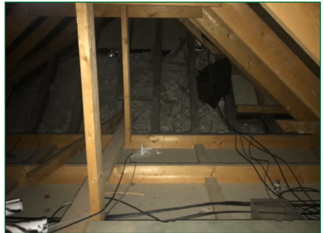
The loft void
