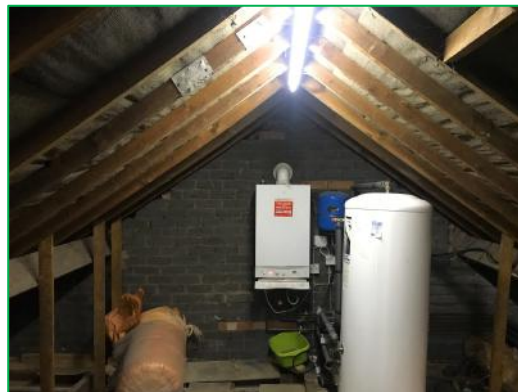
The loft void
