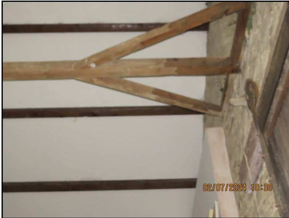
018 Longitudinal timber brace
