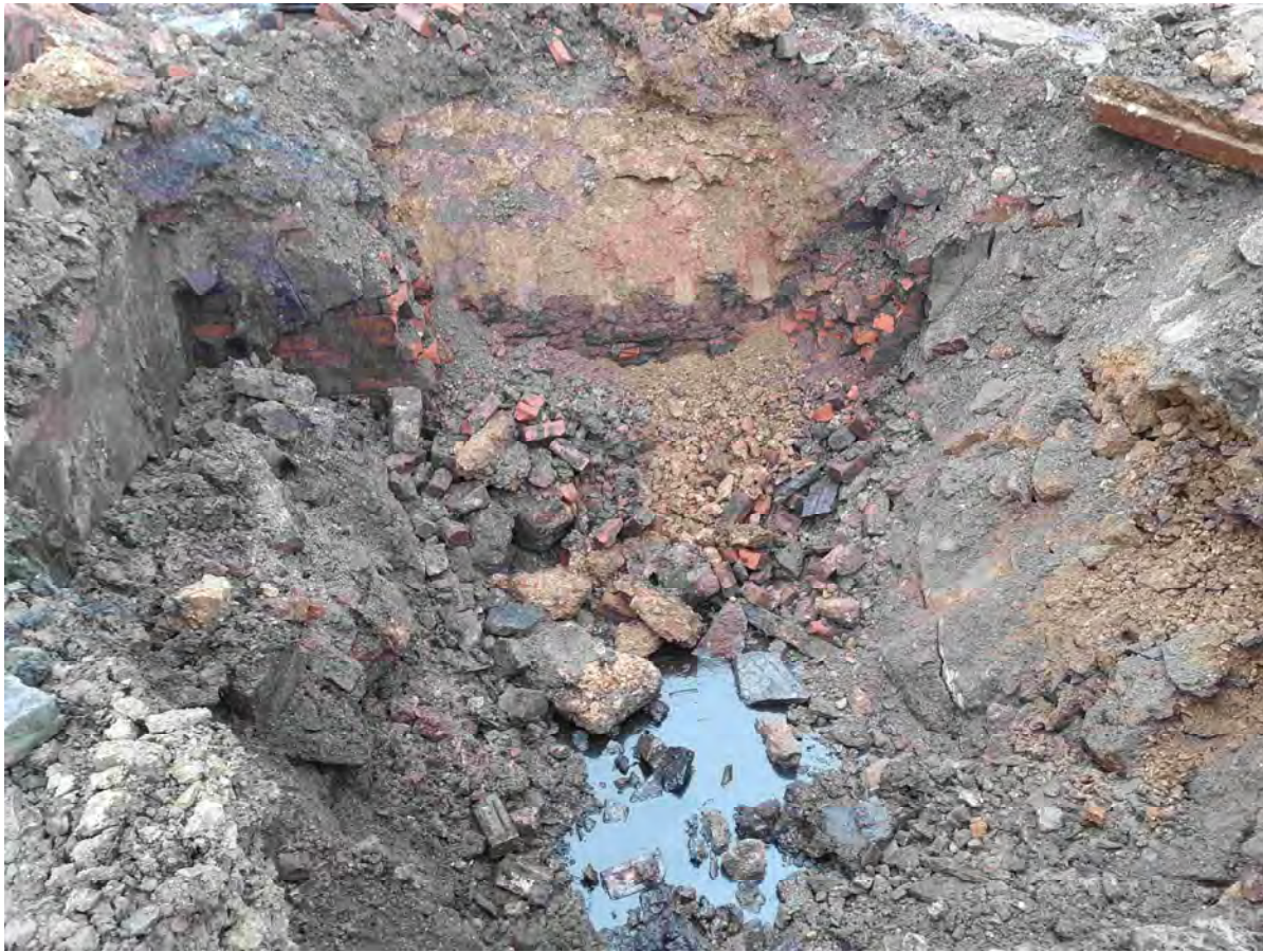
LNAPL at Hotspot 10
