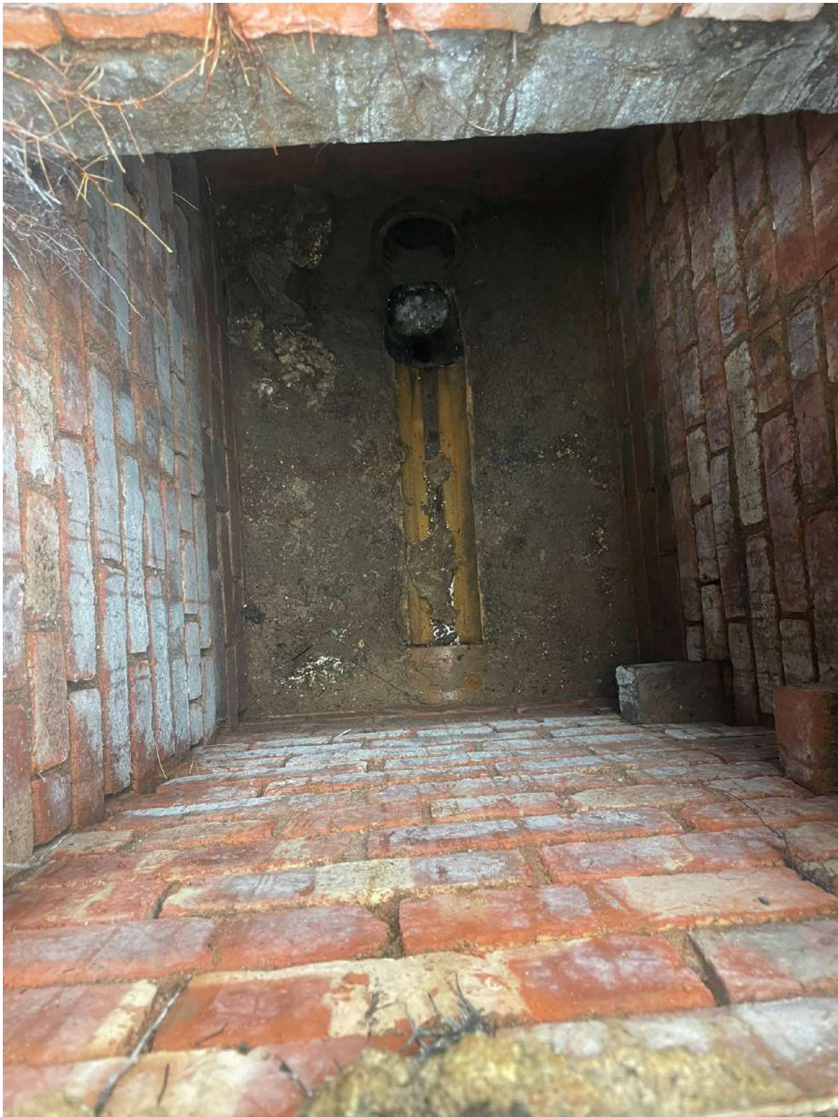
Manhole - MH01 (INTERNAL)
